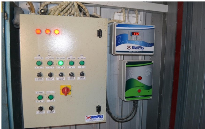
Слика бр. II.25 Систем за следење на хранење и поење на живината
